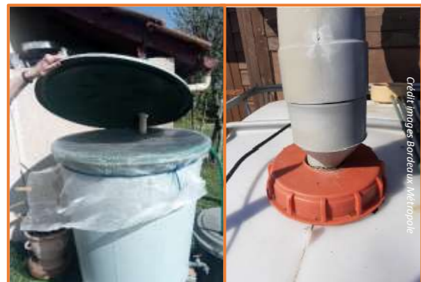
Tulle moustiquaire, raccordement étanche sur réserve d'eau pluviale
