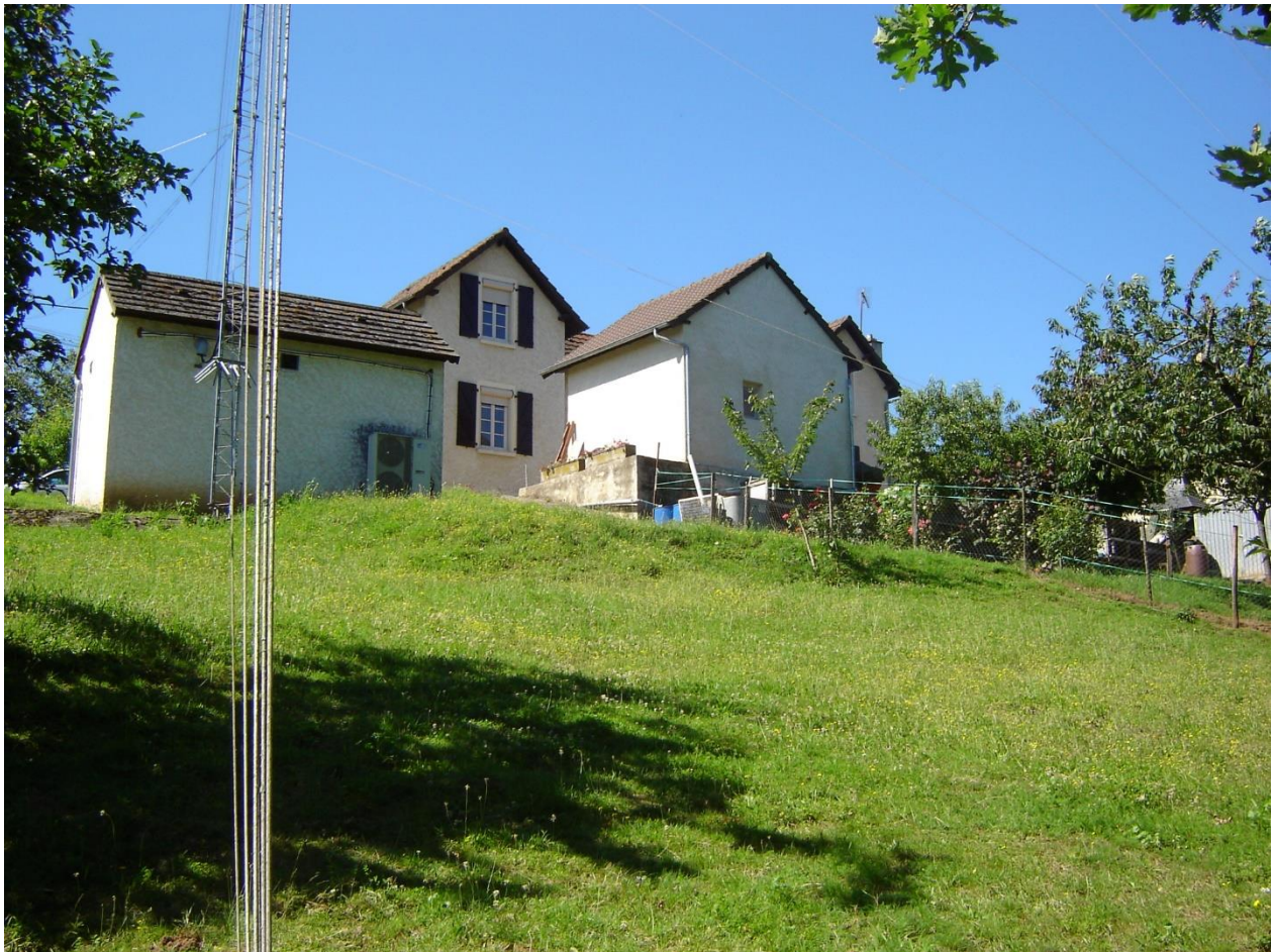
Vue des installations techniques au sol existantes
